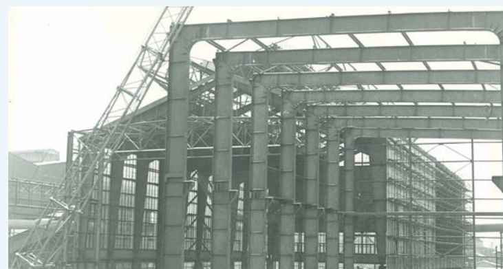
Výstavba haly na výrobu plaveného skla (linka R1), 1967
