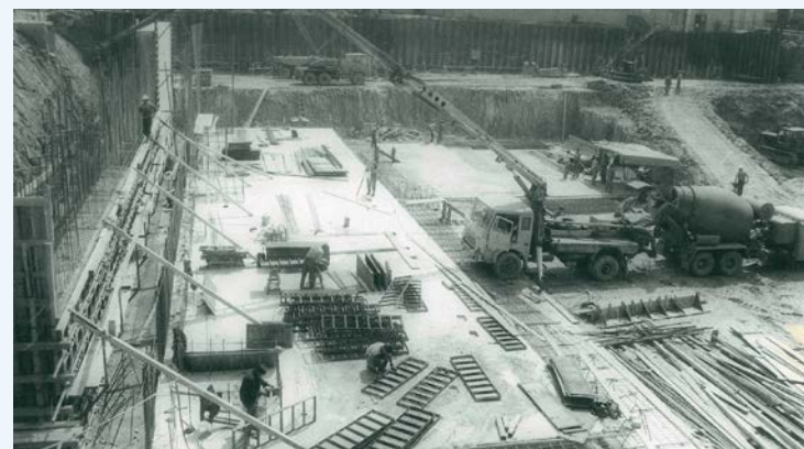
Výstavba haly na výrobu plaveného skla (linka R2), 1984
