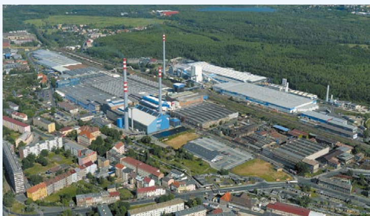
Současný pohled na teplickou sklárnu AGC
